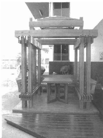
รูปที่ 6 ผลิตภัณฑ์จากวัสดุผสมพีวีซีกับซีลี้อยไม้ยางพาราเป็นศาลาพักผ่อนในสวนหน้าบ้าน
