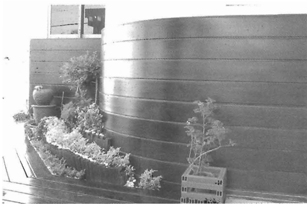
รูปที่ 4 ผลิตภัณฑ์จากวัสดุผสมพีวีซีกับซีลี้อยไม้ยางพาราเป็นวัสดุตกแต่งสวนหย่อม
